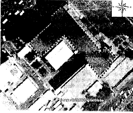
شكل ( ) المبنى الذي يضم معهد التخطيط وجزء من وزارة التخطيط
